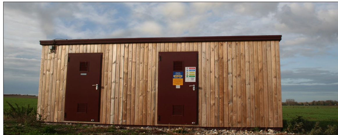
Exemple-type de poste de livraison
